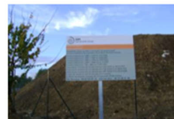
8. Ouverture: travaux préliminaires
