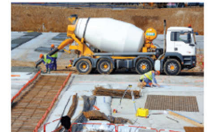
Constructions : fondations, logements, infrastructures, ouvrages d'art, tunnels, ponts...
